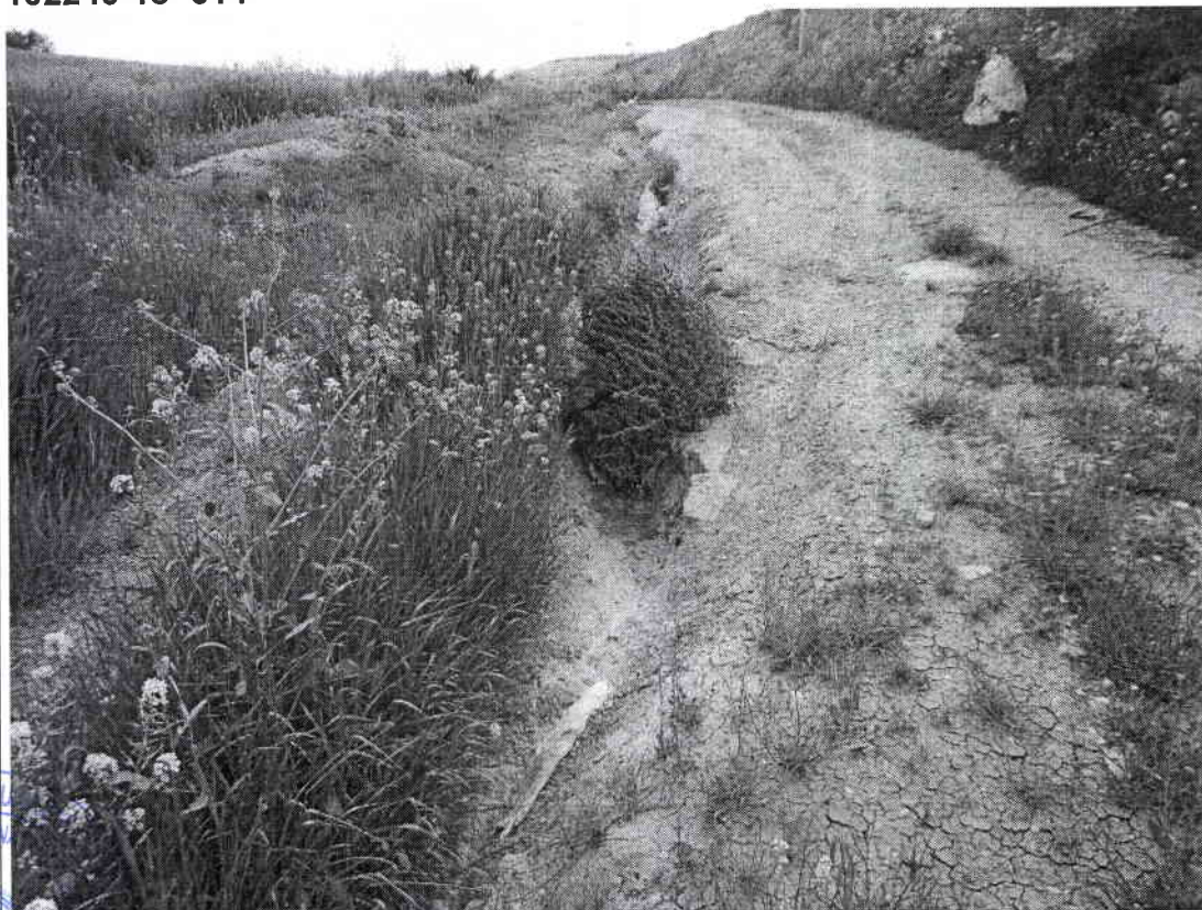
FOTOGRAFÍA Nº 5: IMAGEN DE UNA ZONA DEL CAMINO DONDE SE OBSERVA SU DETERIORO.
