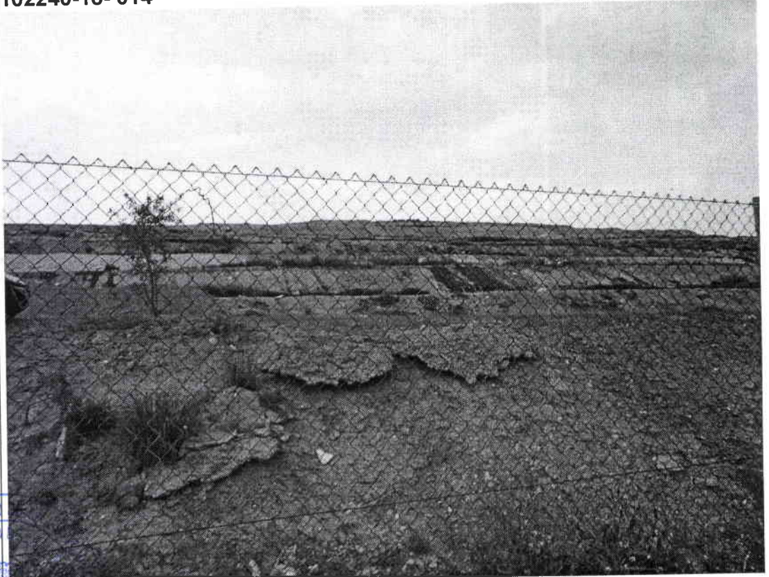
FOTOGRAFÍA N° 19: IMAGEN DE UNA DE LAS ZONAS DEL VERTEDERO DONDE SE APRECIAN LAS CORRENTIAS DE LIXIVIADOS.
